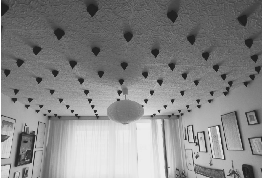
Abb. 3: Die akustisch optimierte Wohnzimmerdecke im Plattenbau
